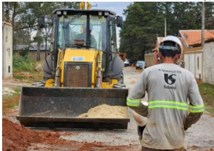
As obras, que já estão em andamento, fazem parte do Programa de Universalização da Sabesp
