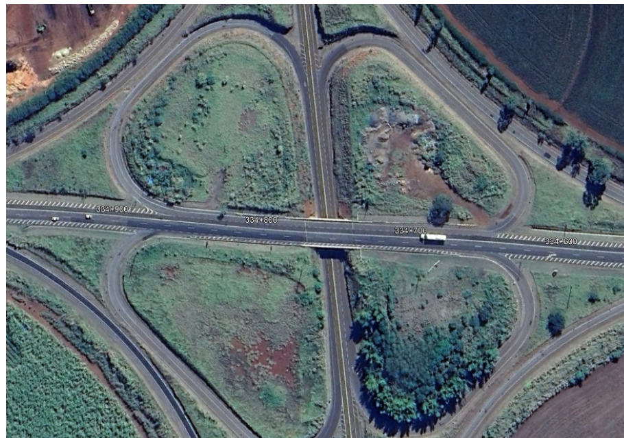
As intervenções vão ocorrer entre 14 de março e 30 de abril, sempre durante o dia, das 7h às 17h
